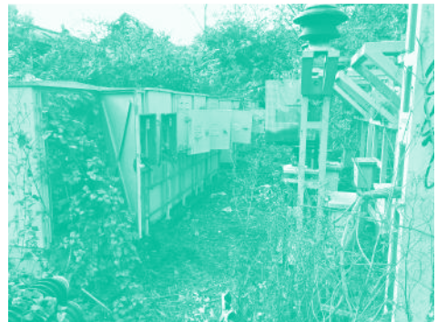
Transformateur en désuétude à Bagnolet. Source : Novaxia.
