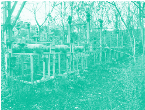
Transformateur en désuétude à Bagnolet. Source : Novaxia.
