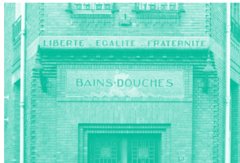
Façade des anciens bains-douches de la rue Castagnary dans le XV e arrondissement de Paris. Photo : Laurent Kruszyk, Région Île-de-France.
